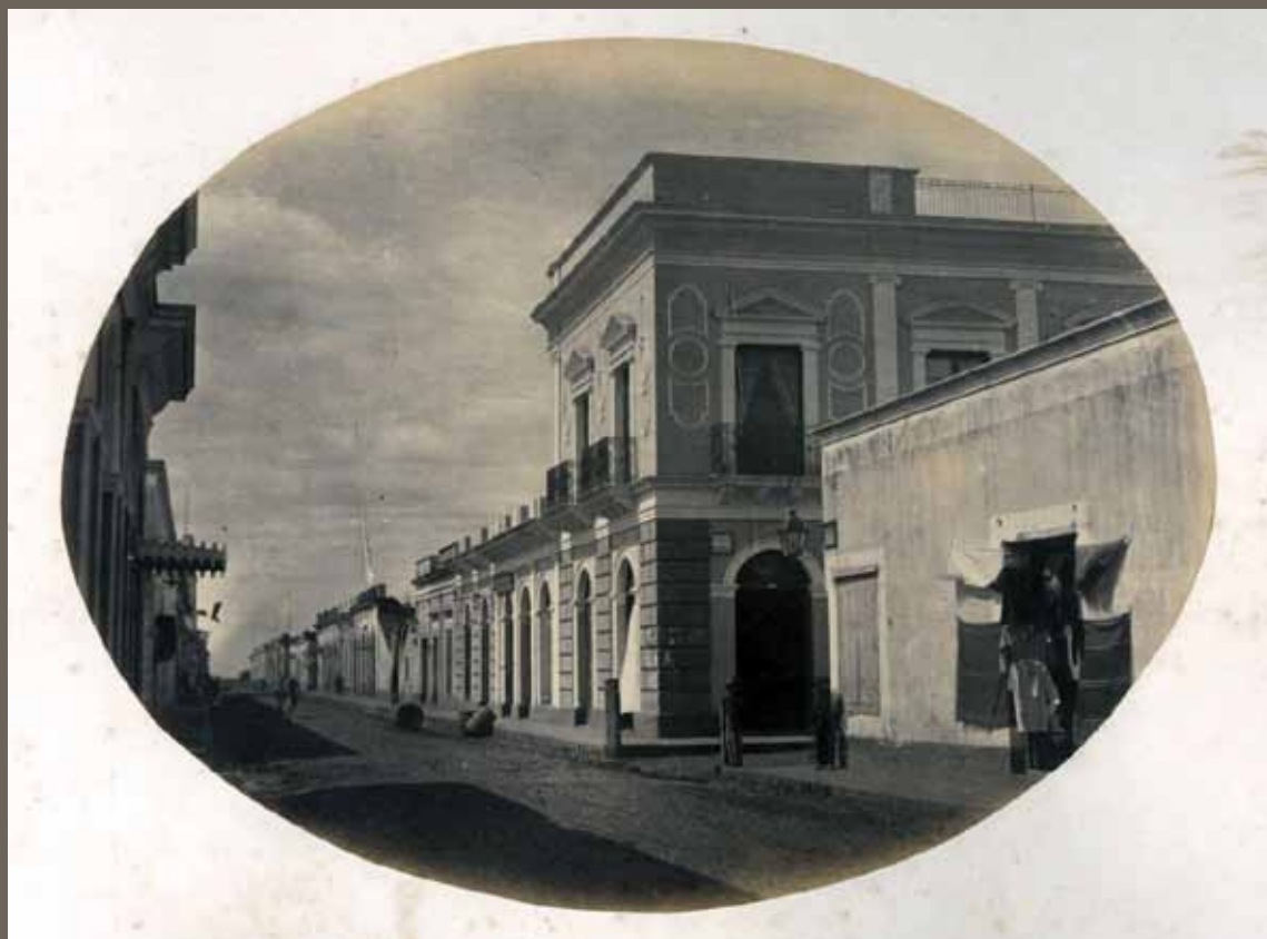
ESQUINA PUERTO (HOY SAN MARTÍN Y CÓRDOBA)
